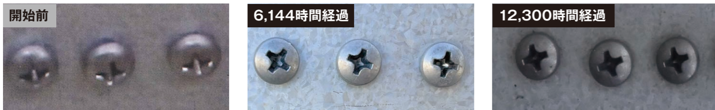
電食は発生していない
