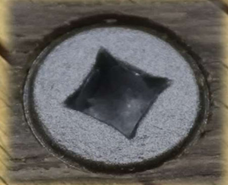
バリキル施工後の仕上がり (頭部塗装品) ※先孔なし・座グリなし一発施工写真
